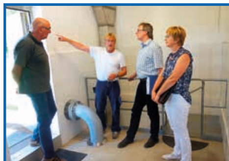
Wasserwerk Wöhlsdorf – Ralf Schröter (2. von li.) als einer von 6 Anlagenüberwachern im Trinkwasserbereich erläutert unterschiedliche Druckverhältnisse.
