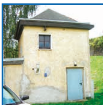
PW II alter Zustand
