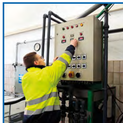
Mitarbeiter Peter Hanl bei der Feinjustierung der Polymerzugabe an der Schlammmentwässerung
