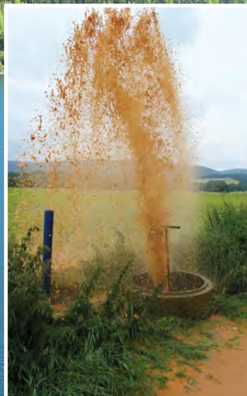
Spülung der Rohwasserleitung Brunnen-galerie Saaleaue des Wasserwerks Wöhlisdorf
