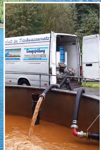
Saugspülvorrichtung auf Fahrzeug – Rohwasserleitung TWA Gräfenthal
