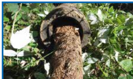
Verstopfte Rohre durch Wurzeln
