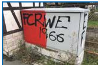
Schaltschrank Bereich Rudolstadt
