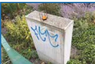
Schaltschrank Bereich Rudolstadt
