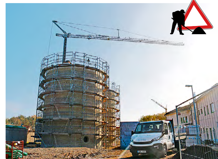
Unter anderem zwei neue Faultürme sollen zur Energieoptimierung der Kläranlage beitragen. Foto: SPREE-PR / Schulz
