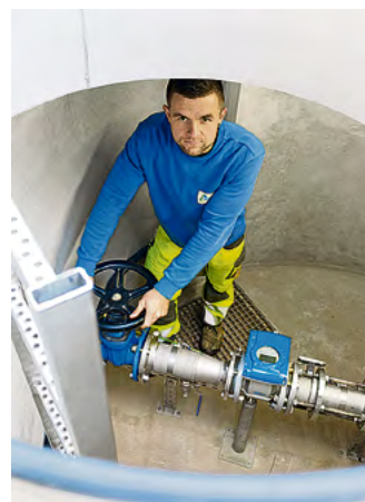
↑ Rein in die gute (Brunnen-)Stube: Michel Königer kontrolliert, ob der Rohwasserzufluss ins Wasserwerk auch ordnungsgemäß funktioniert.
