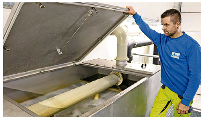
↑ Im Wasserwerk wird das Trinkwasser entsäuert, um alle Parameter der Trinkwasserverordnung einzuhalten. Michel Königer schaut hier, ob die Kreuzstrombelüftungsanlage ordnungsgemäß funktioniert.
