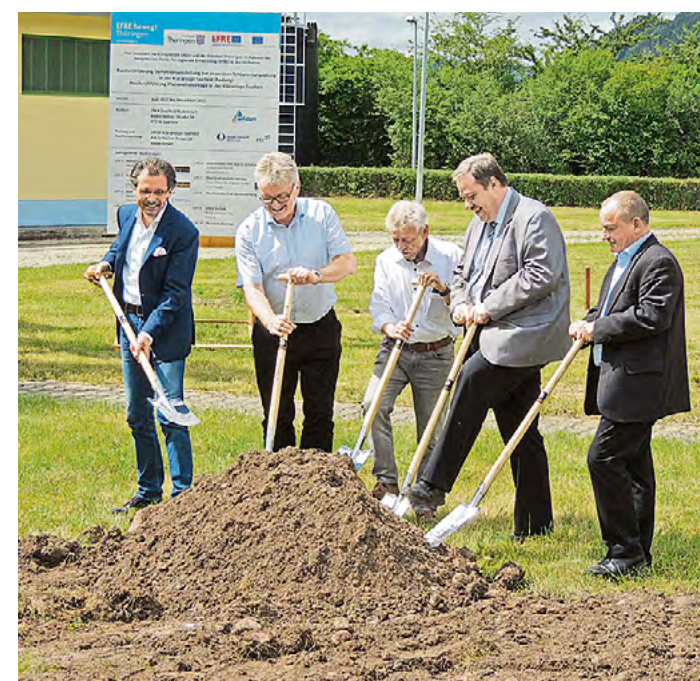
Im Juli erfolgte per Spatenstich der Startschuss zur Modernisierung der Saalfelder Kläranlage. Foto: ZWA Saalfeld-Rudolstadt
