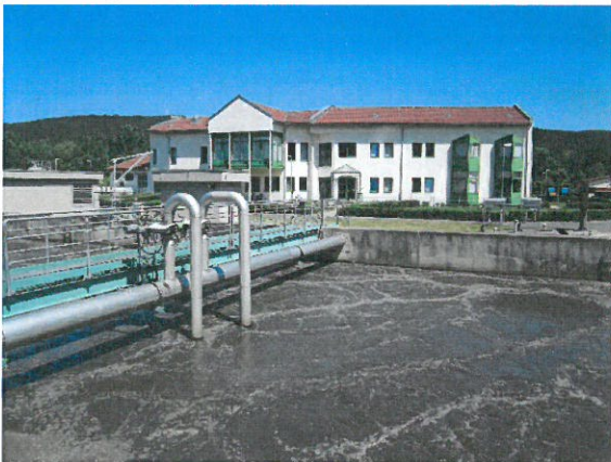
Belebungsbecken und Betriebsgebäude
