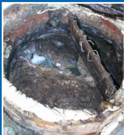
Absetzgrube mit gravierenden baulichen Mängeln
