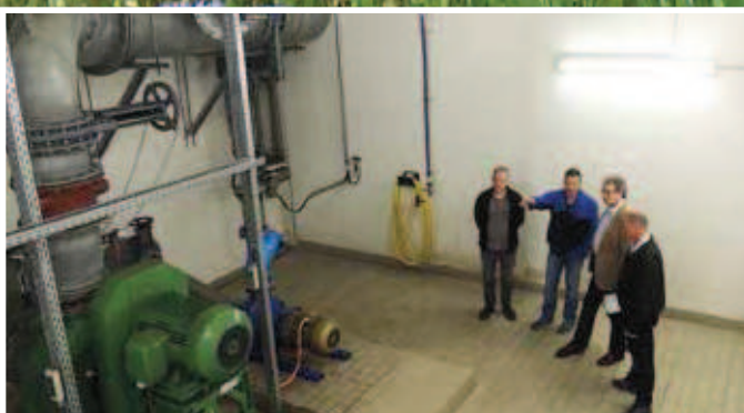
Kläranlage Rudolstadt – Erläuterung vorgenommener Optimierungen durch Pumpenaustausch mit Schwerpunkt Energieeffizienz.
