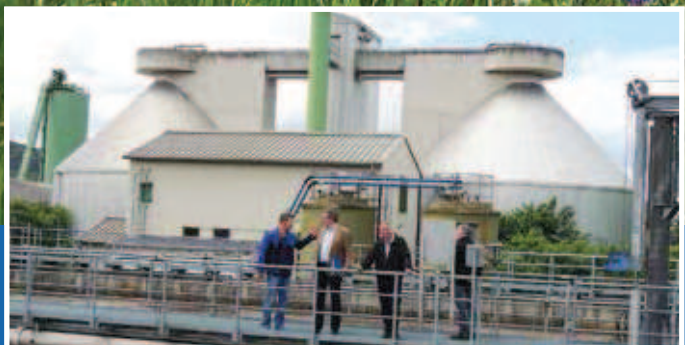
Kläranlage Rudolstadt – 2 Faultürme (Bildhintergrund) stehen für Eigenstromerzeugung. Genug, um beide Gasmotoren im dortigen Blockheizkraftwerk zu betreiben (2014 allein 700.000 kWh/a).
