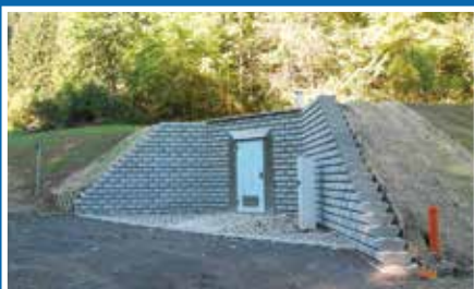
Der neue Quellschacht mit Fassungsanlage im „Kalkgrubental“
