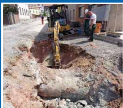
Unter Vollsperrung der B 88 erfolgt momentan die Verlegung der Mischwasserkanalisation mit Regenwasserbehandlung in Kirchhasel.
