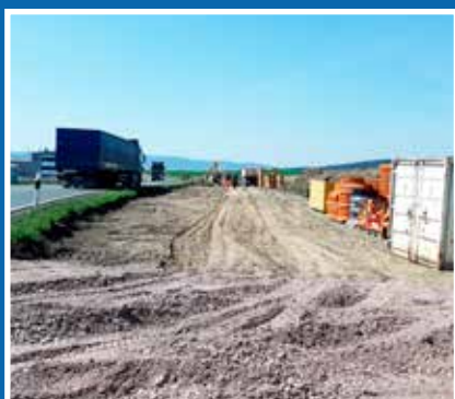
Um die Abwässer des OT Birkigt der Gemeinde Unterwellenborn der Kläranlage Saalfeld zuführen zu können, sind einige Vorarbeiten erforderlich. Momentan erfolgt der Bau eines Schmutzwassersammlers parallel zur B 281. Noch in diesem Jahr ist die Errichtung des Hauptpumpwerks Birkigt sowie der Bau der Abwasserdruckleitung bis zum Anschluss an den Schmutzwassersammler geplant.
