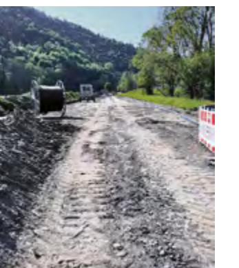
Abzweig Marktgrößt bis Ortseingang Oberloquitz: Verlegung von etwa 1.500 m Trinkwasserverbindungsleitung und ca. 1.300 m Abwasserdruckleitung. Fotos: ZWA
