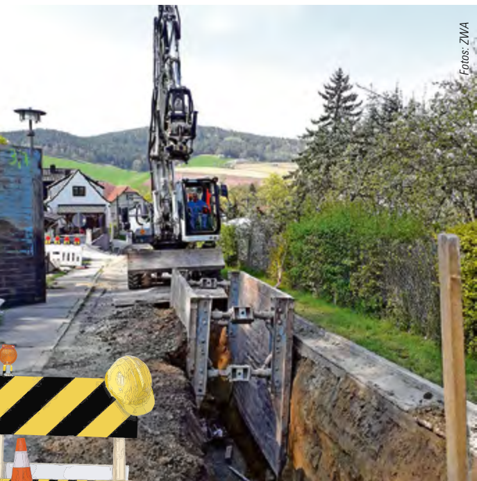
Teichröda: Für den Anschluss an die Kläranlage Rudolstadt wird die Kanalisation erneuert.
