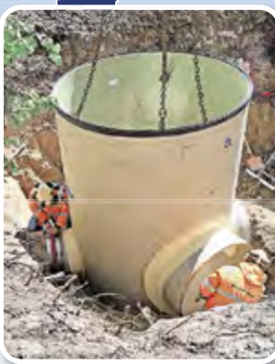
Über dieses Schachtwerk wird Hauptsammler H an Regenüberlaufbecken H angeschlossen.
