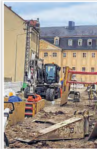
▲ Trink- und Abwasserleitungen müssen erneuert und erweitert werden.
