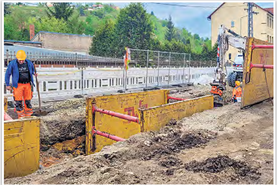
▲ Die Baumaßnahme auf der B 85 ist ein Großprojekt und gehört zu den umfangreichsten der letzten Jahre in der Region Rudolstadt.
