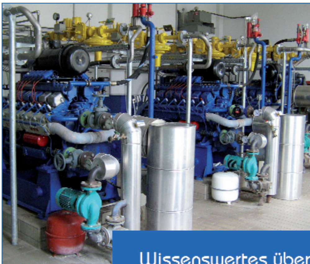
Blockheizkraftwerk der Kläranlage Rudolstadt
