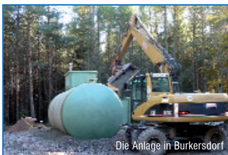
Baugrube für den neuen Hochbehälter
