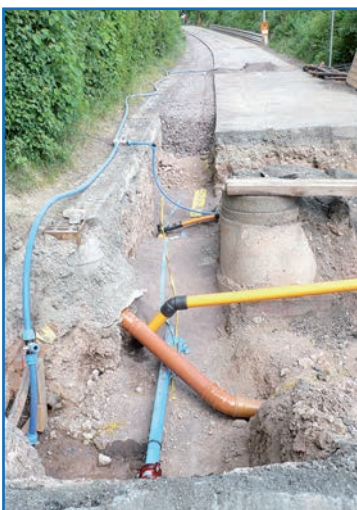
Erneuerung der Trinkwasserleitung in der Schlossstrasse in Rudolstadt
