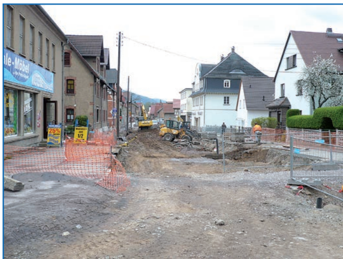
Verlegung Kanalisation und Trinkwasserleitung in der Schwarzburger Straße in Rudolstadt - Schwarza
