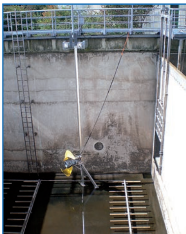
Belebungsbecken der Kläranlage Rudolstadt, Belüfter und Tauchmotorrührwerk
