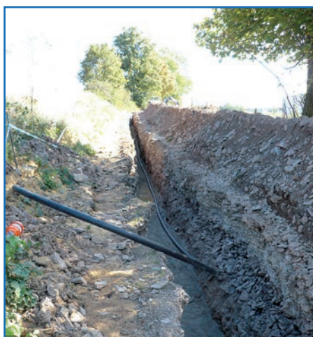
Verlegung der Versorgungsleitung von Munschwitz nach Leutenberg
