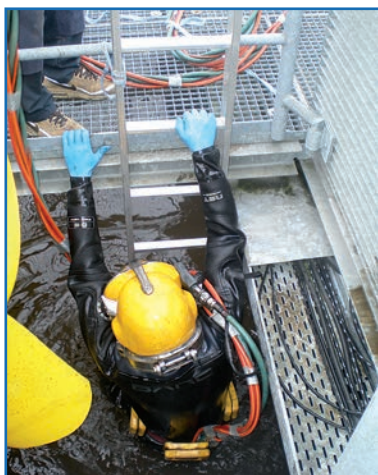
Taucher beim Wechseln der Rührwerke
