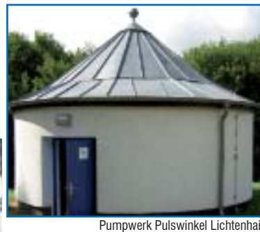
Pumpwerk Pulswinkel Lichtenhain
