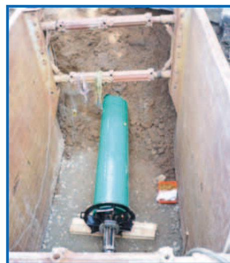
Zielgrube mit eingezo-genem Kanal DN 450
