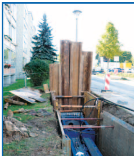
Berstanlage in der Startgrube
