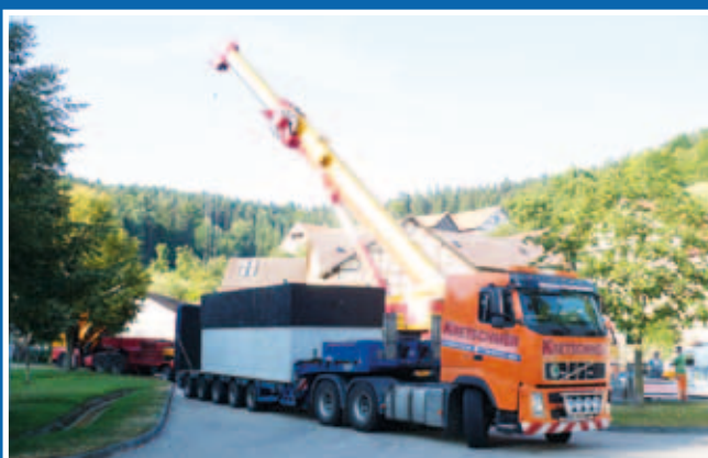
Setzen des Pumpwerkes mit Behälter 10 m 3 im Bereich des Dorfplatzes
