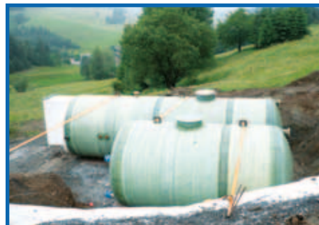
Speicherbehälter 2 \times 30 \text{ m}^3 in der Bauphase
