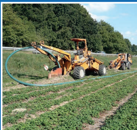
Einpflegen der Abwasserdruckleitung von Watzdorf nach Bad Blankenburg
