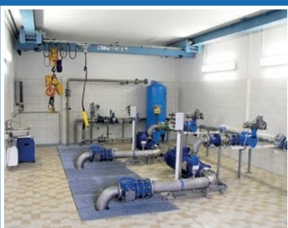
Trinkwasserpumpwerk Ammelstädt Anlagenoptimierung durch Pumpenaustausch mit Schwerpunkt Energieeffizienz
