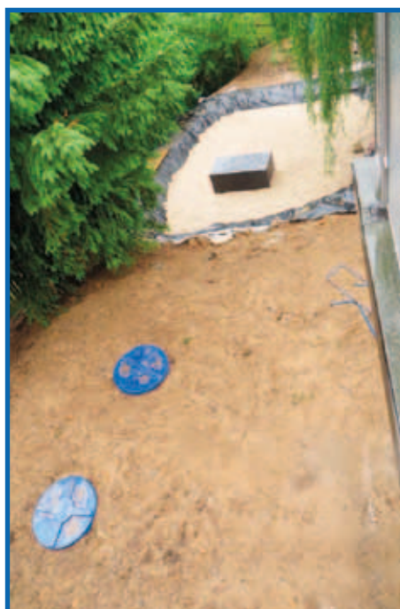
Blick auf die Pflanzenkläranlage der Fam. Fröchtling in Saalfeld vor dem Einbringen der Pflanzen; im Vordergrund ist die Abdeckung einer ausreichend dimensionierten Vorklärlung zu erkennen.
